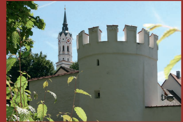
St. Jakob mit Stadtmauer
