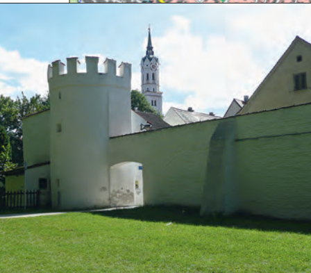
Stadtmauer in Schrobenhausen
